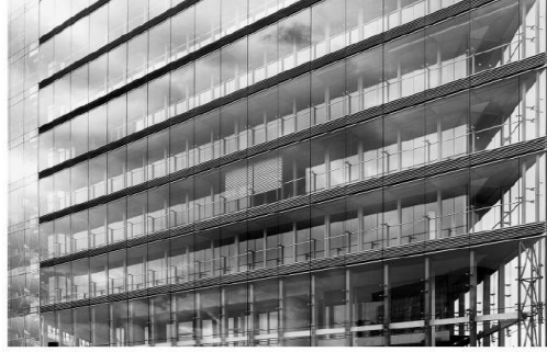
الشكل (20): مبنى شتادتور في دوسيلدورف [5]
