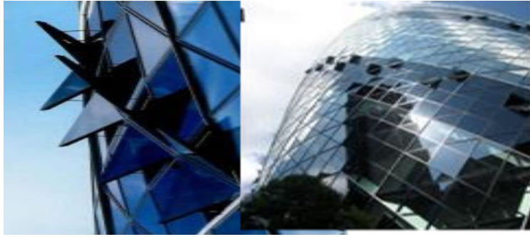
الشكل(17):مبنىSwiss re tower[ 3]
