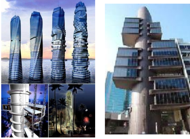
شكل ٥: توضيح الدور الإنشائي الخدمي لبطارية الخدمة
