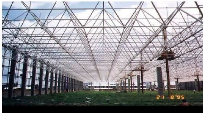
الاستقرار الديناميكي وفيه تنتقل الاحمال في اتجاهات المنشأ ومن امثلة ذلك الجمالونات الفراغية والمنشآت ذات الكبلات المشدودة
